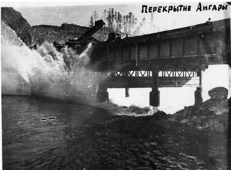
Второе перекрытие Ангары, 1959 год.
