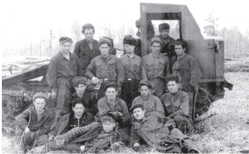
Бригада строителей ЛЭП-500кВ Братск - Иркутск Федора Мишенина (3-й ряд, 2-й справа), 1-й ряд (лежат, справа В. Скурковин - комсорг стройки), Братский район, август 1959 года
