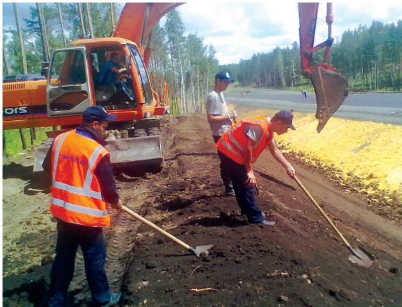
Стройотрядовцы БрГУ на строительстве автодороги М-53
