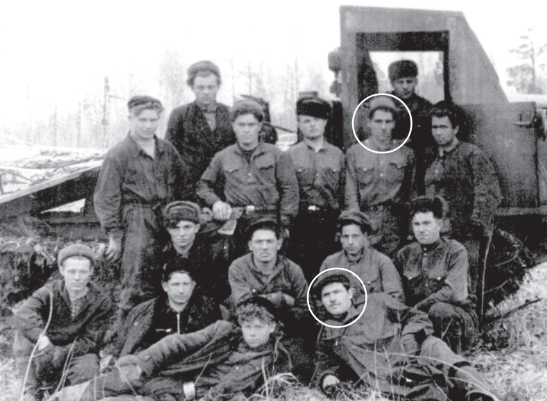
На фото из личного архива В.К.Скуркина бригада строителей ЛЭП-500 Братск - Иркутск под руководством Федора Мишенина (третий ряд, второй справа), в первом ряду (первый справа) комсорг стройки Виктор Скурковин.
