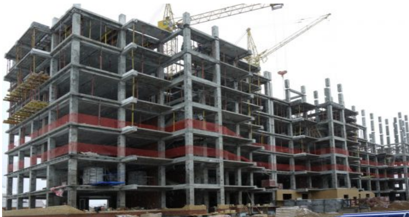
Рис. 1. Монолитное каркасное здание
