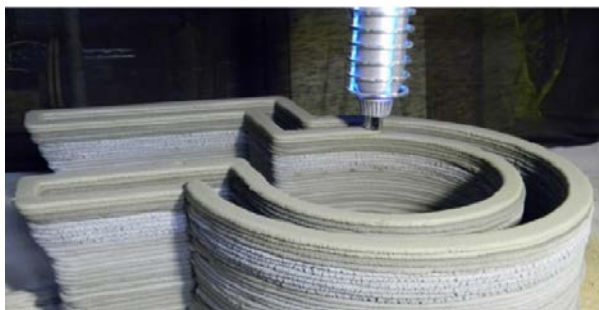
Рис. 4. Изготовление сооружения методом послойного экструдирования
