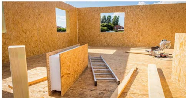
Рис. 3. Возведение здания из СИП-панелей
