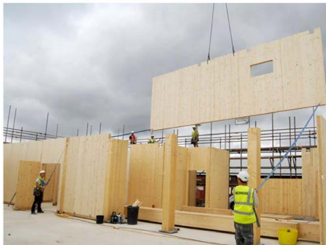
Рис. 6. Монтаж здания из CLT-панелей
