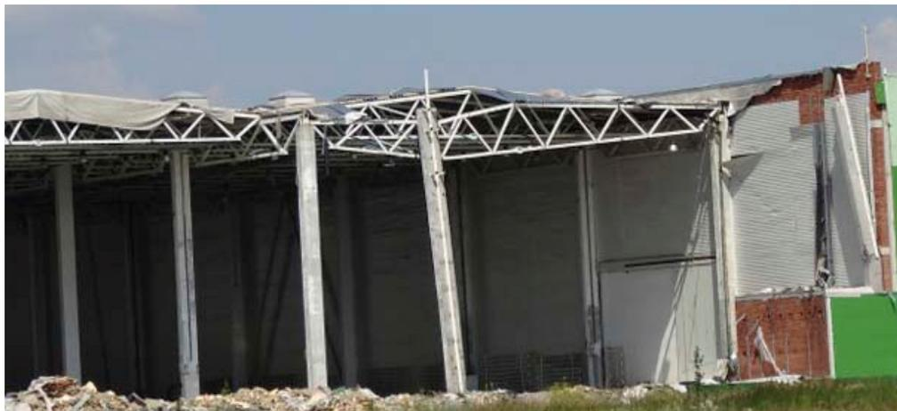
Рис. 1. Разрушения крыши здания из ЛСТК.
