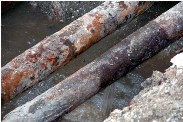
Рис. 1. Наружная коррозия тепловых сетей
