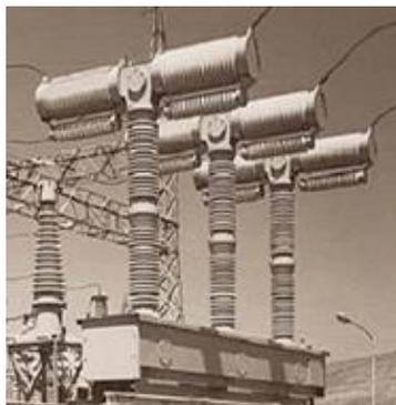
Рис. 3. Двухразрывный вакуумный выключатель VCB 168 кВ/31,5 кА/2000 А
