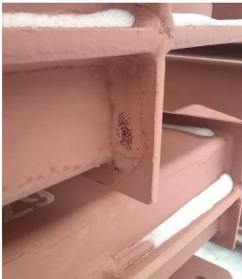
Рис.2. Дефект сварного соединения в виде пор
