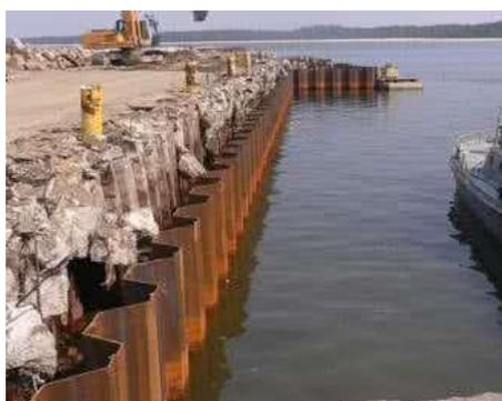
Рис. 2. Использование шпунтов для укрепления береговой линии
