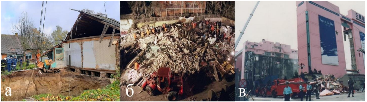
Рис. 1. Аварийные случаи обрушения
