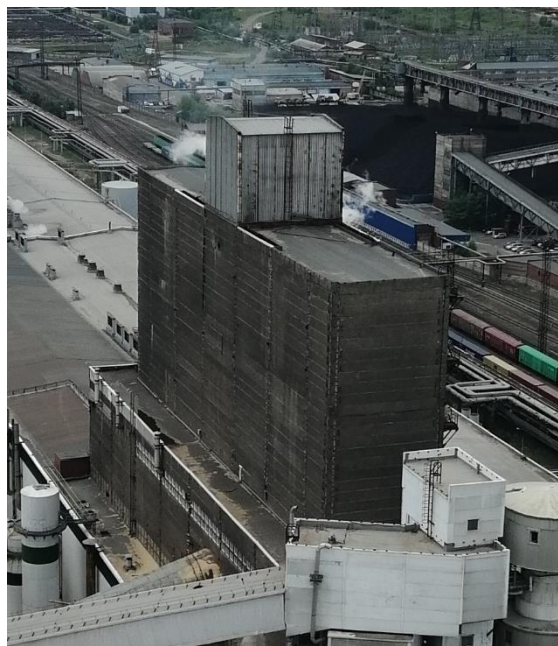
Рис. 1. Варочный цех ПЛЦ
