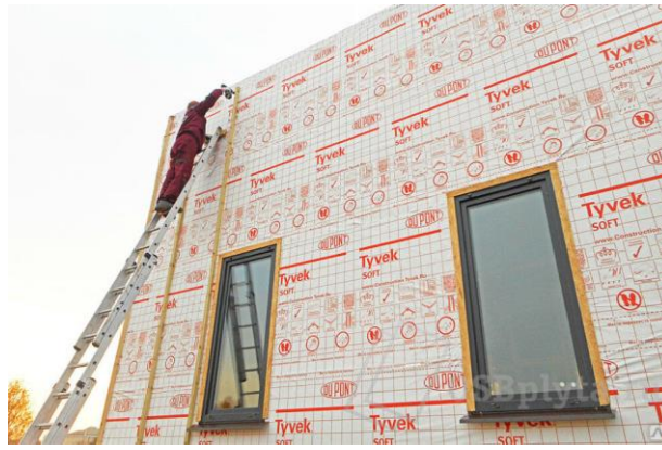
Рис. 2. Пример гидроветрозащитной пленки «Тайвек»
