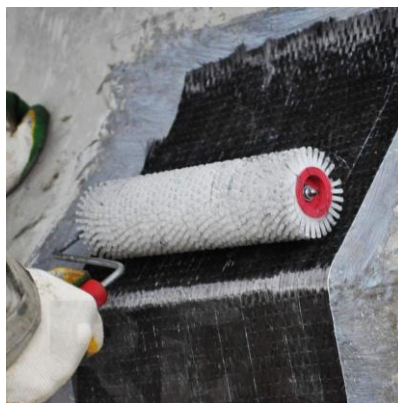
Рис.3. Усиление железобетонной конструкции углепластиковым холстом
