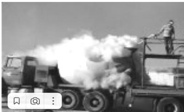
Рис. 2. Охлаждение свежеприготовленной бетонной смеси жидким азотом
