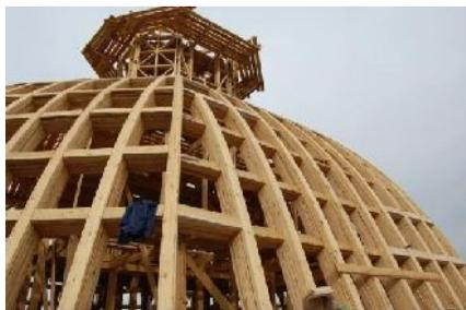
Рисунок 1 – Каркасное сооружение из дерева
