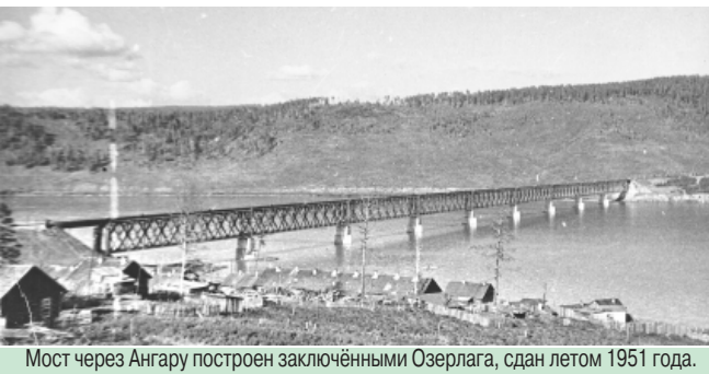
Мост через Ангару построен заключёнными Озерлага, сдан летом 1951 года.
