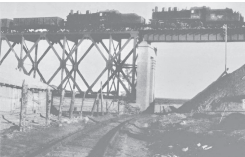
Испытания моста у старого Братска на западном участке БАМа, 1951 год. На мосту паровозы Эм. Под мостом - типичная картина лагерного строительства: барак и колючая проволока.
