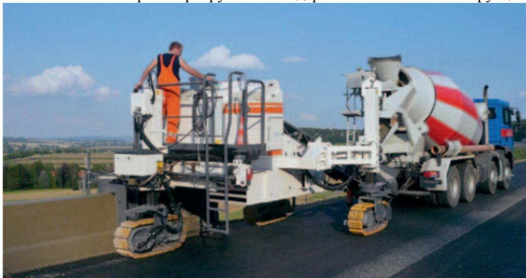
**Рис. 1. Бетонукладчик со скользящими формами SP 150**
