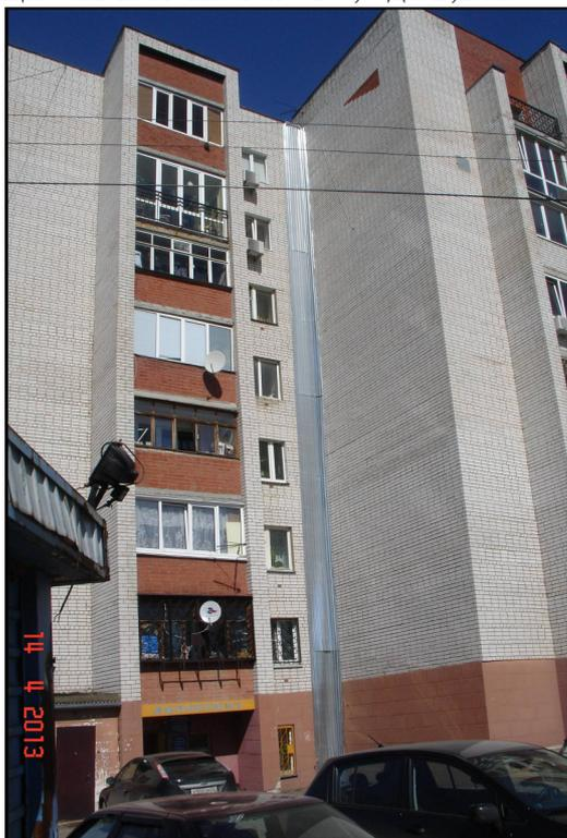
**Фото 1.** Апрель 2013 года. Секция №2 (на фото слева) отделена от секции №1 (справа) вертикальным температурным швом (вид со стороны оврага – см. рис.2)
